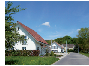
Dorfeingang Wasterkingen altes Zollhaus Foto: H. Gut
