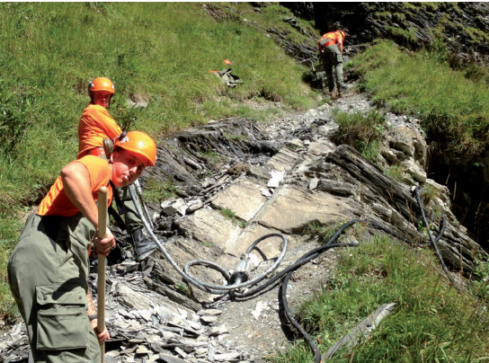
Bergweg in der Tschinglenschlucht. Einsatz von Abbauhämmern zum Spitzten von Tritten in den Fels.
