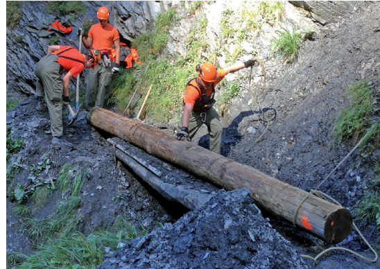
Bergweg in der Tschinglenschlucht. Brückeneinbau.
