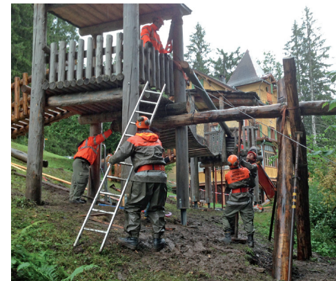
Spielplatz, Ferienhaus Engi. Sanierung Holzkonstruktion.
