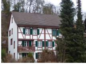
Riegelhaus Unterdorfstrasse (Südansicht) Foto: Kurt Gut
