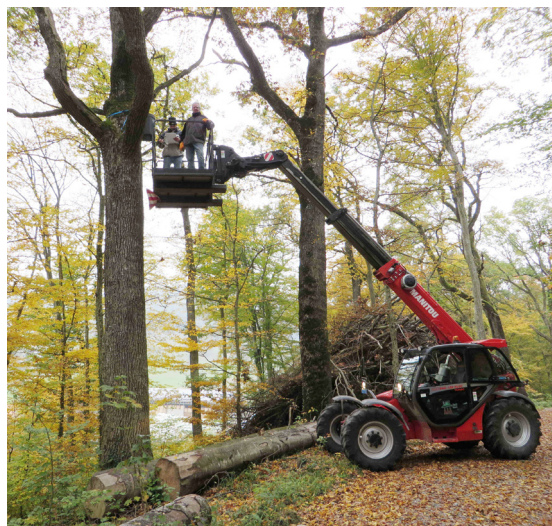
Einfacher in dieser Höhe zu arbeiten mit technischer Unterstützung
